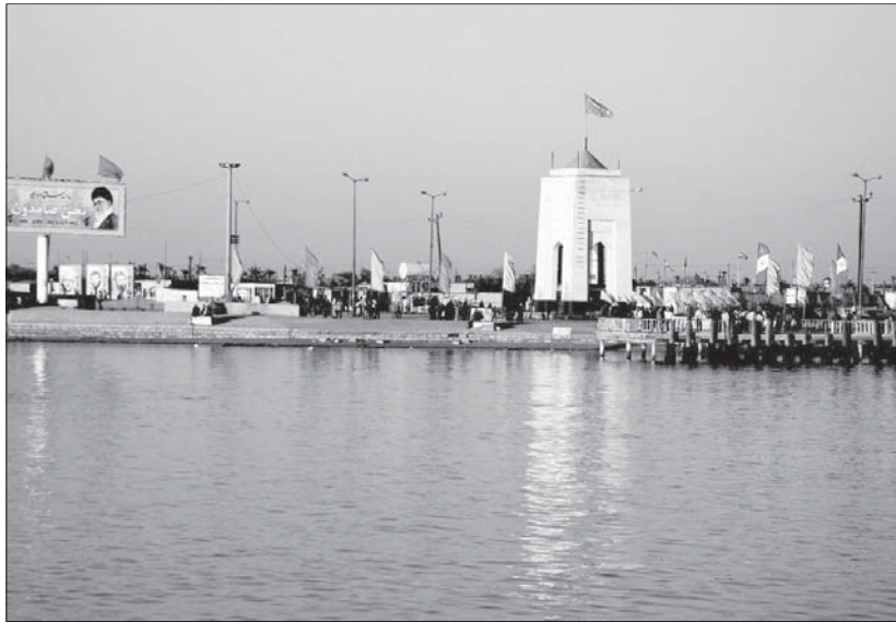
یادمان شهدای عملیات والفجر ۸، اروندکنار، استان خوزستان.
