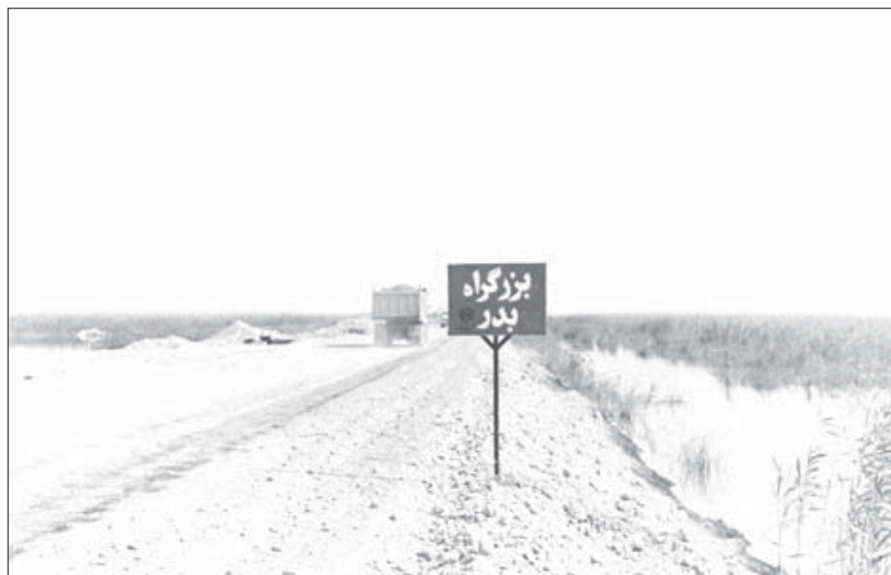
جاده بدر به طول ۸ کیلومتر در عملیات بدر در منطقه جزیره مجنون شمالی با همکاری پشتیبانی و مهندسی جنگ جهاد احداث شد.
