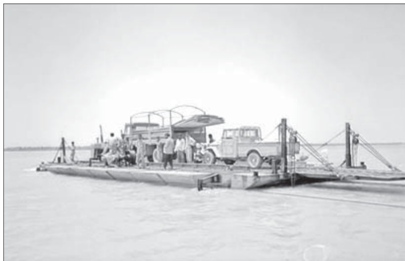
پل خضر جهاد سازندگی به وسیله یک تراکتور و سیم بکسل هدایت می‌شد، پل شناوری برای نقل و انتقال ادوات و تجهیزات بود.
