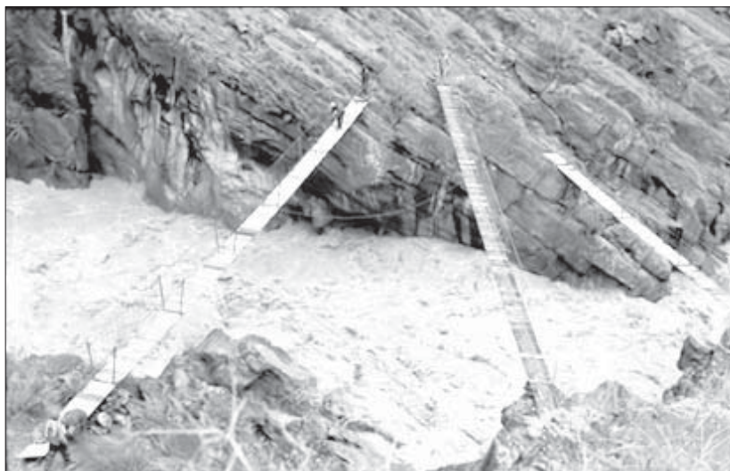
احداث پل نفر روکابلی برای سهولت تردد رزمندگان در ارتفاعات صعب‌العبور در جبهه‌های غرب روی رودخانه قلعه چولان توسط جهاد سازندگی طراحی و نصب می‌شد.
