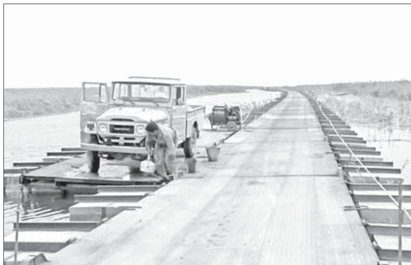
کار طراحی و ساخت پل شناور خیبر، به طول ۱۴ کیلومتر و عرض ۴ متر و ۲ متر بال محافظ، به همت نیروهای جهاد سازندگی با هدف برقراری ارتباط بین جزیره مجنون و ساحل خودی انجام شد.
